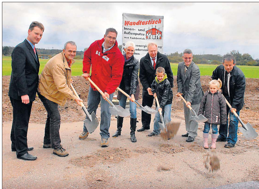
Erster Spatenstich: Daniel und Alexandra Schneider (Dritter und Vierte von links) geben gemeinsam mit OB Wolfgang Gerstner (Fünfter von links) den Startschuss zum Neubau. Foto: Gernsbeck
